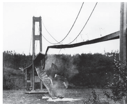
Sabrukušais tilts pār Takomas šaurumu.
